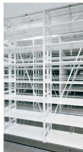
背面ブレースによる補強
